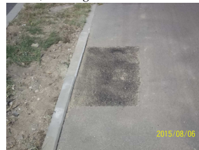
źle wykonana "łata" - niedowalowane , masa gruboziarnista
