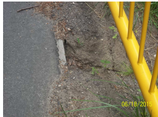
Przepusty - luźne kamienie zabruku do ponownego montażu
