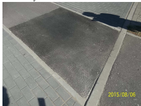
źle wykonana "łata" - niedowalowane , masa gruboziarnista
