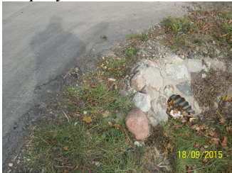
Przepusty - luźne kamienie zabruku do ponownego montażu
