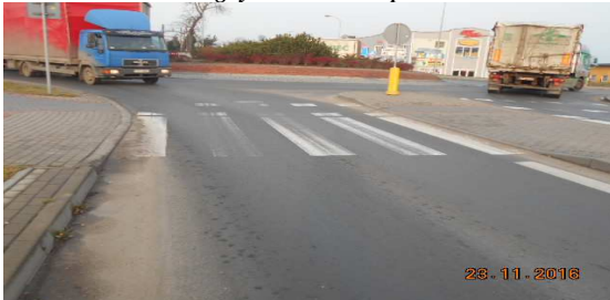
Oznakowanie poziome Ponowne malowanie gdy oznakowanie poziome widać w mniej niż 50 % , malowanie pojedynczych elementów
