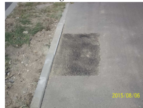
źle wykonana "łata" - niedowalowane , masa gruboziarnista
