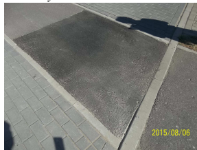
źle wykonana "łata" - niedowalowane , masa gruboziarnista
