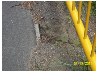
Przepusty - luźne kamienie zabruku do ponownego montażu
