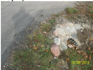
Przepusty - luźne kamienie zabruku do ponownego montażu
