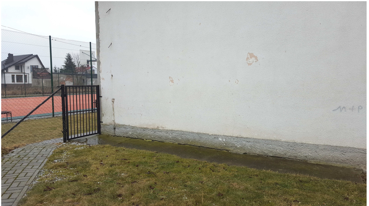
Rys.1 Ściana zewnętrzna istniejącego budynku szkoły w rejonie otworu A.
