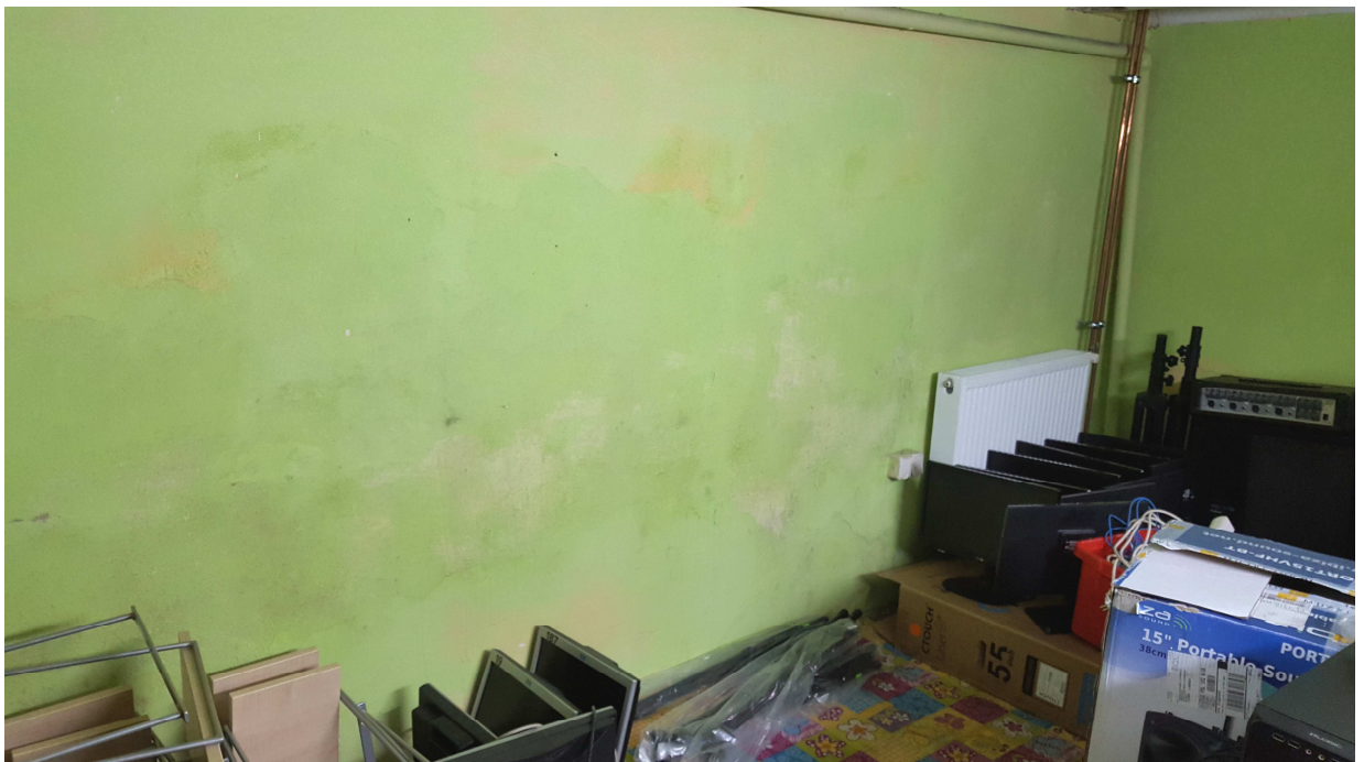
Rys.2 Pomieszczenie bez wilgoci w piwnicy budynku szkoły w rejonie otworu A.
