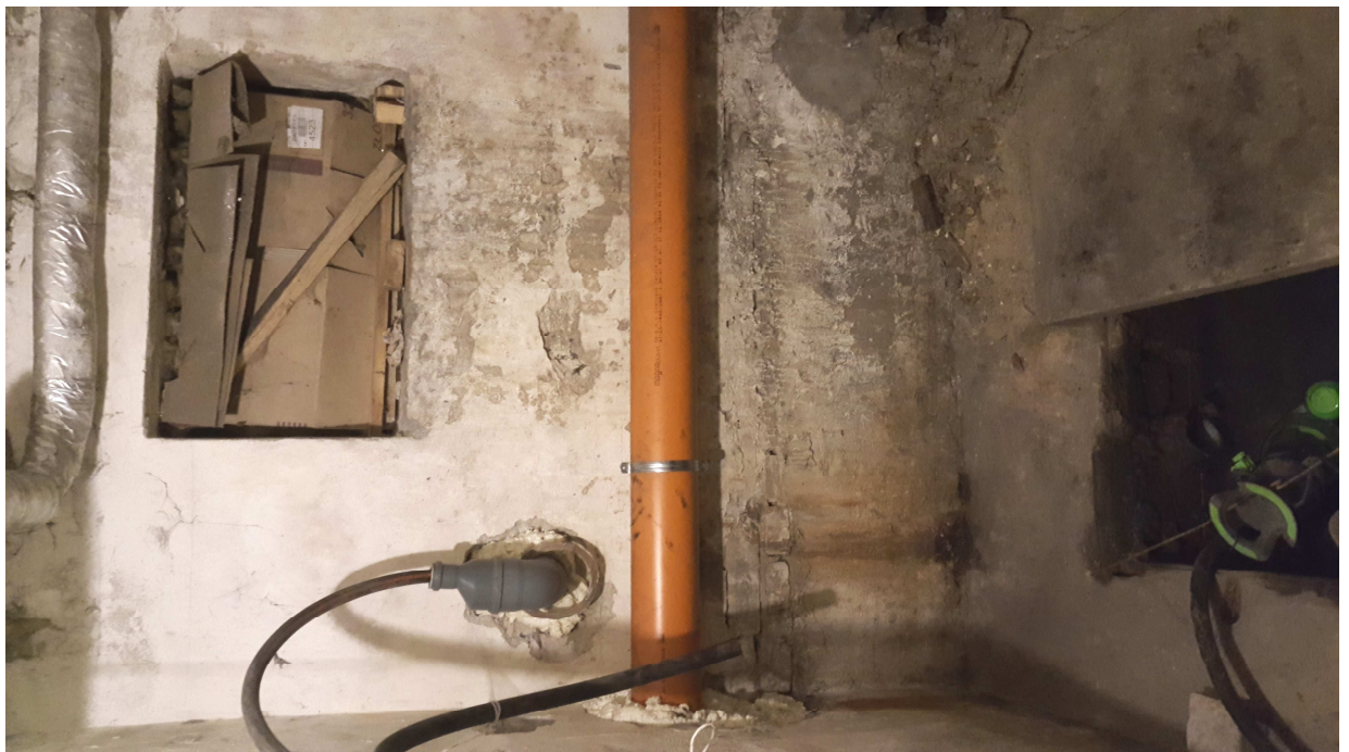
Rys.4 Pomieszczenie zawilgocone w piwnicy budynku szkoły w rejonie otworu AII.
