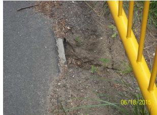
Przepusty - luźne kamienie zabruku do ponownego montażu
