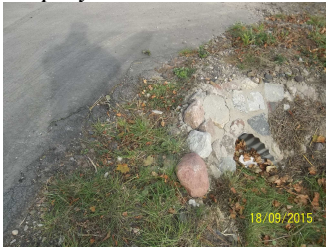
Przepusty - luźne kamienie zabruku do ponownego montażu
