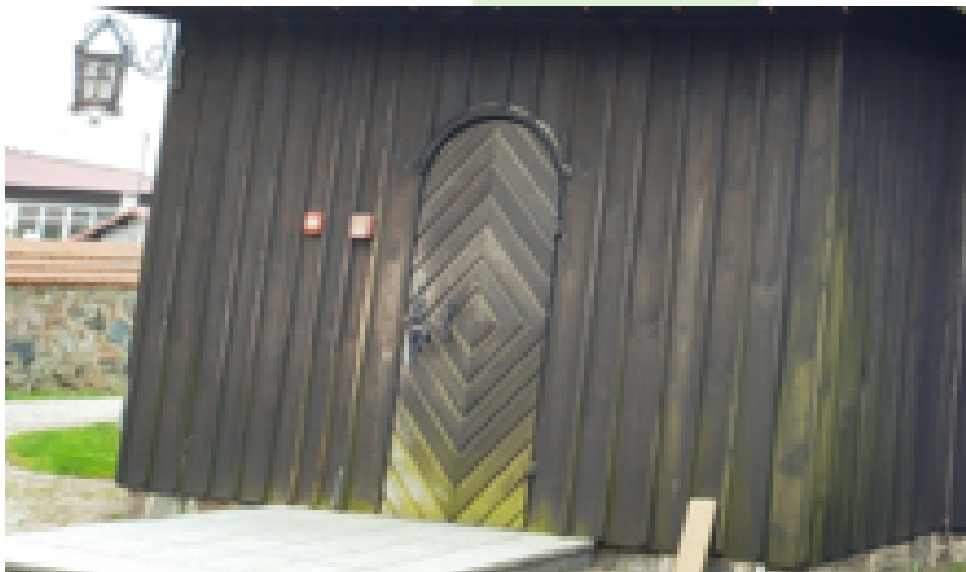
Zdjęcie 5: Stolarka drzwiowa - widoczne występowanie glonów i porostów
