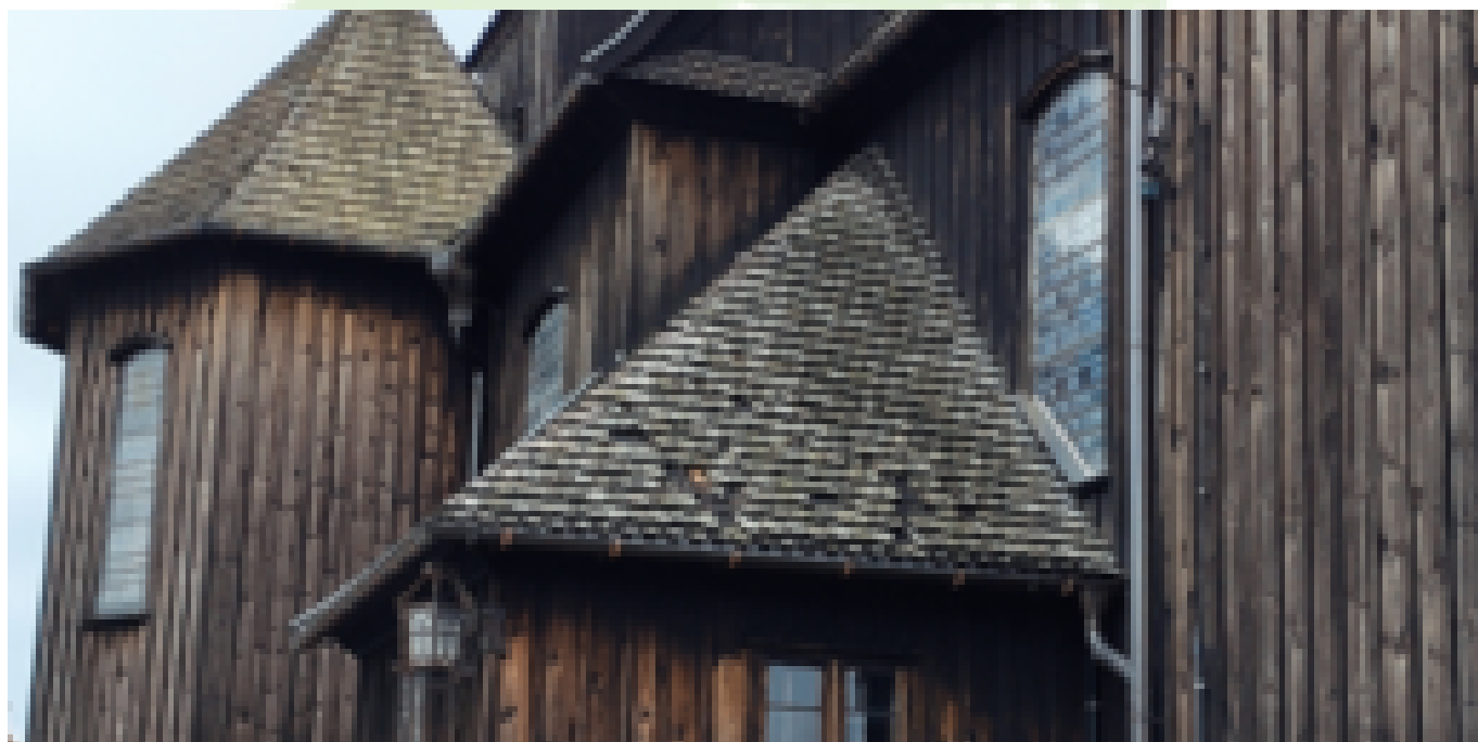
Zdjęcie 4: Gont drewniany - widoczne ubytki i zabrudzenia
