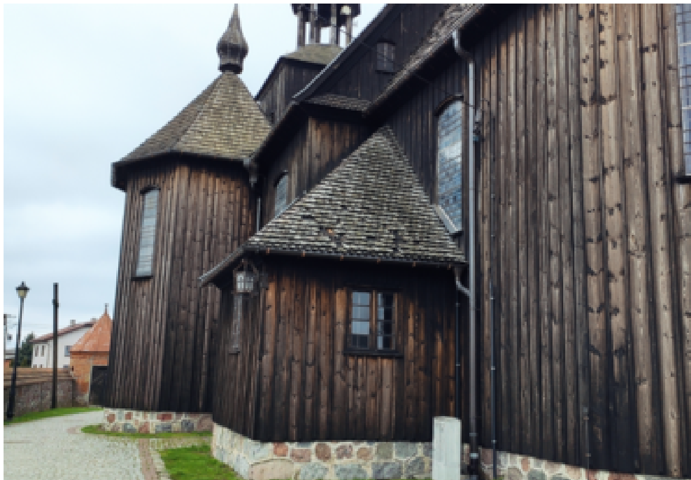
Zdjęcie 2: Elewacja południowa - widoczne przebarwienia i wysuszenia spowodowane promieniowaniem UV
