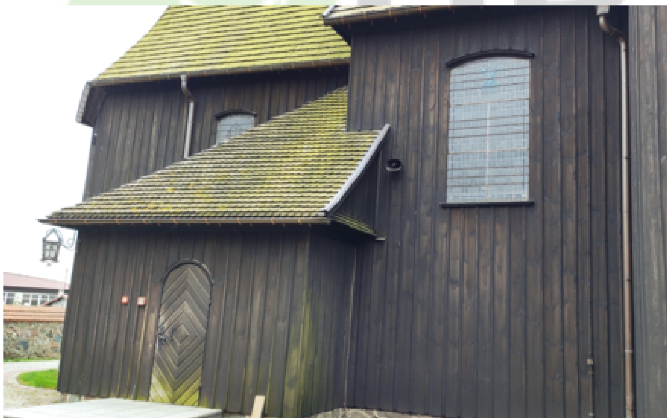
Zdjęcie 3: Elewacja północna - widoczne występowanie glonów i porostów
