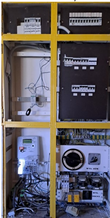
Rysunek 2 Rozdzielnica główna
