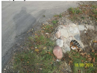
Przepusty - luźne kamienie zabruku do ponownego montażu
