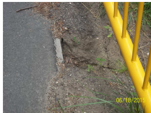
Przepusty - luźne kamienie zabruku do ponownego montażu
