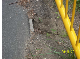
Przepusty - luźne kamienie zabruku do ponownego montażu
