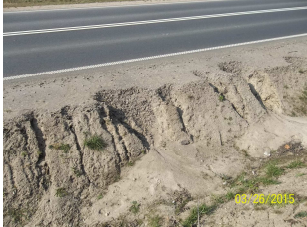
Przepusty - luźne kamienie zabruku do ponownego montażu
