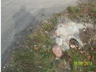
Przepusty - luźne kamienie zabruku do ponownego montażu
