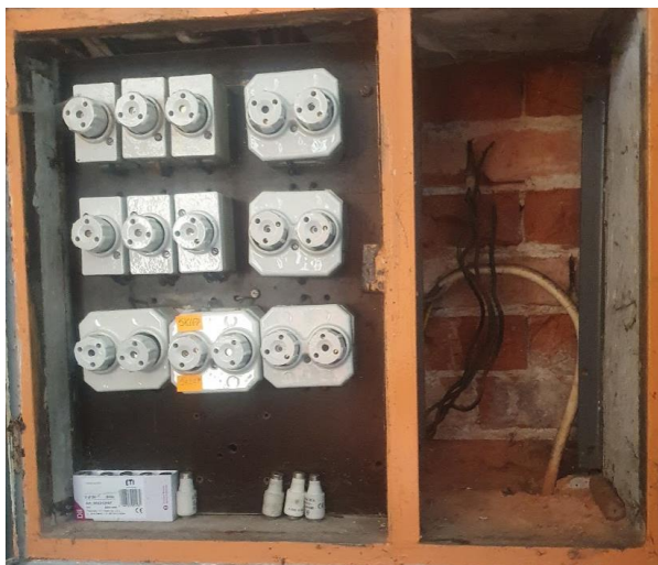
Rysunek 1 Rozdzielnica RG do wymiany
