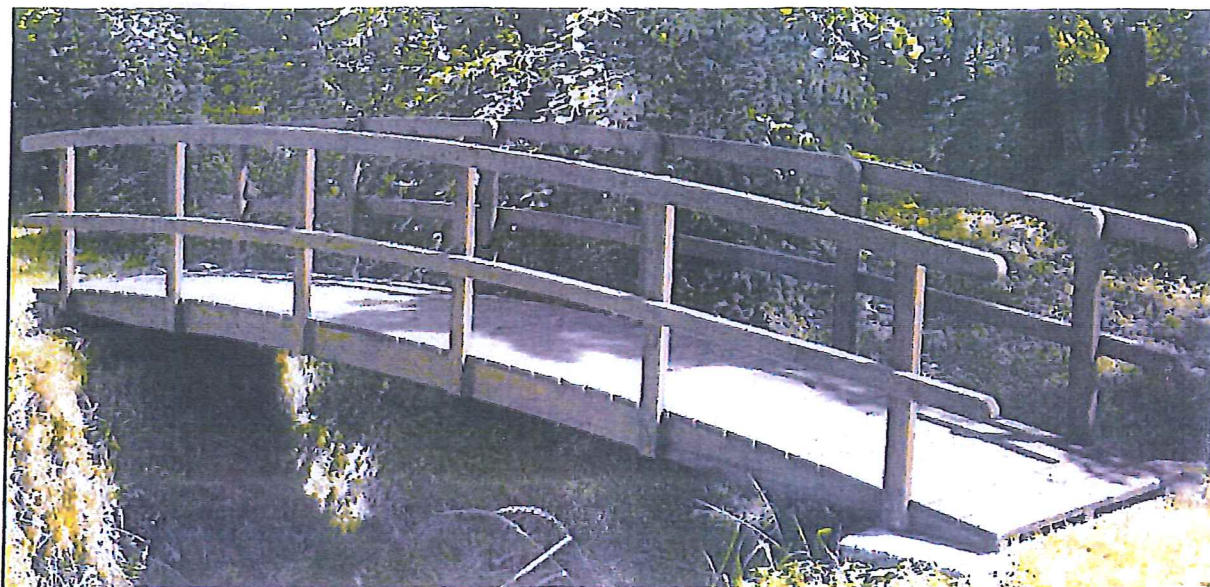
mostek - utwardzenie ścieżki -drewno świerkowe - szerokość 150cm, długość 6m element gotowy
